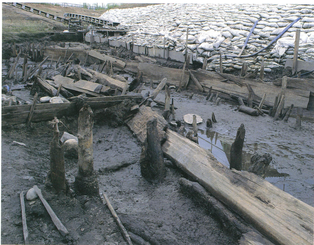
3区 S D27護岸施設（北西から）
