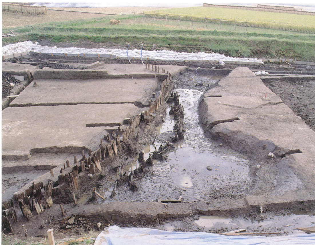
1区SD11矢板列検出状況（北から）
