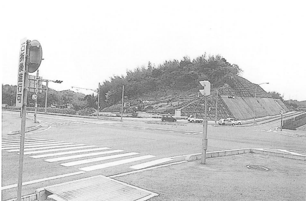
7. 調査前風景 (南より)
