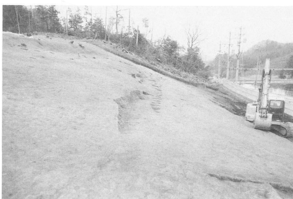
柵列 1 完掘 (南より)
