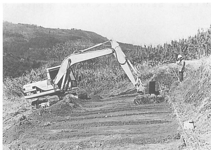
写真① 石脇第3遺跡森末地区 重機表土剥ぎ作業
