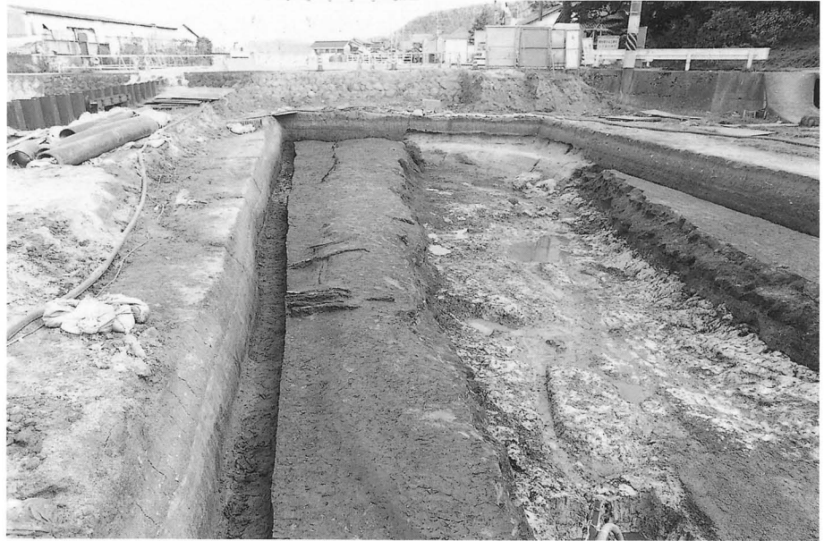
1. 3区水田畦畔 (西より)
