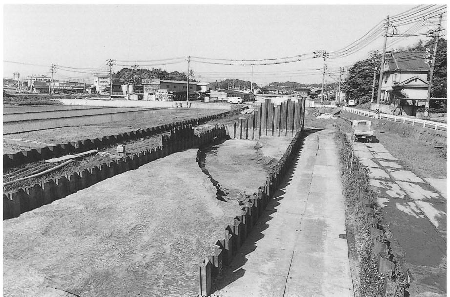
3. 1区水路3 上層完掘(南西より)
