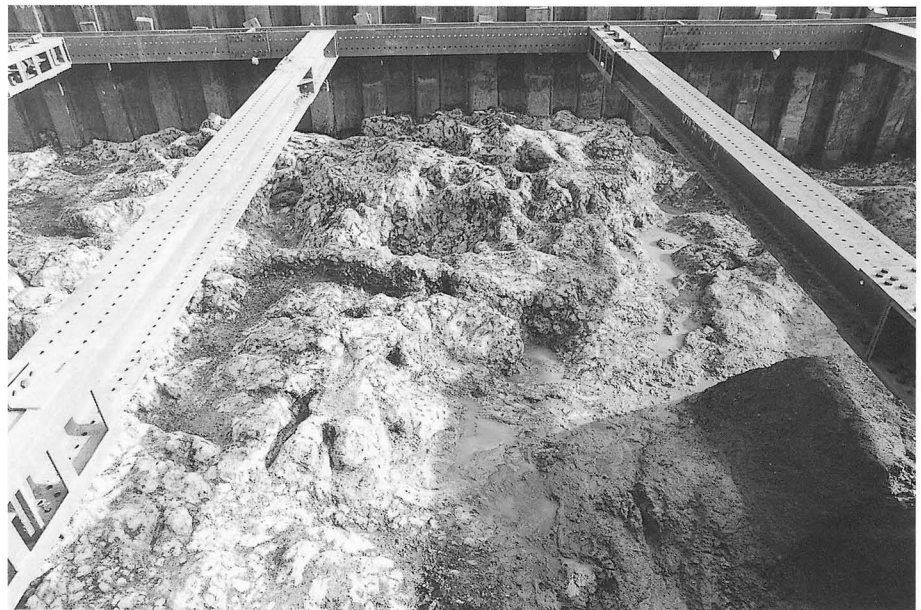
2. 1区縄紋時代層 完掘(北より)
