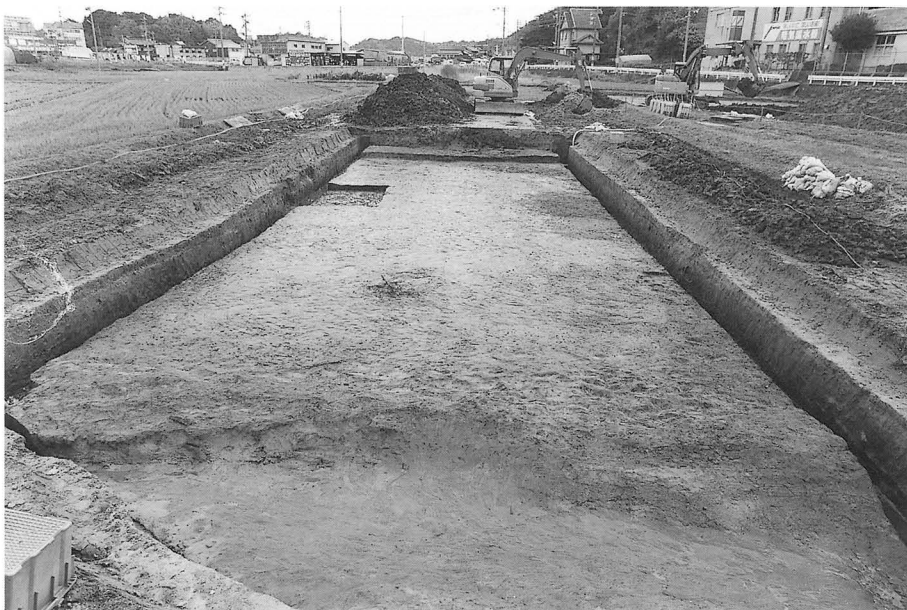
2. 水田面検出 (西より)
