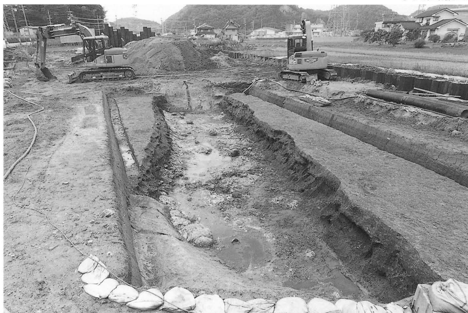
1. 3区水路3 完掘(東より)
