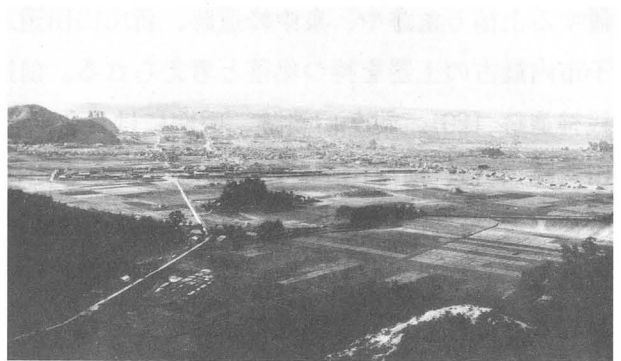
写真1 明治時代の目久美 （『新修米子市史』第13巻より）
