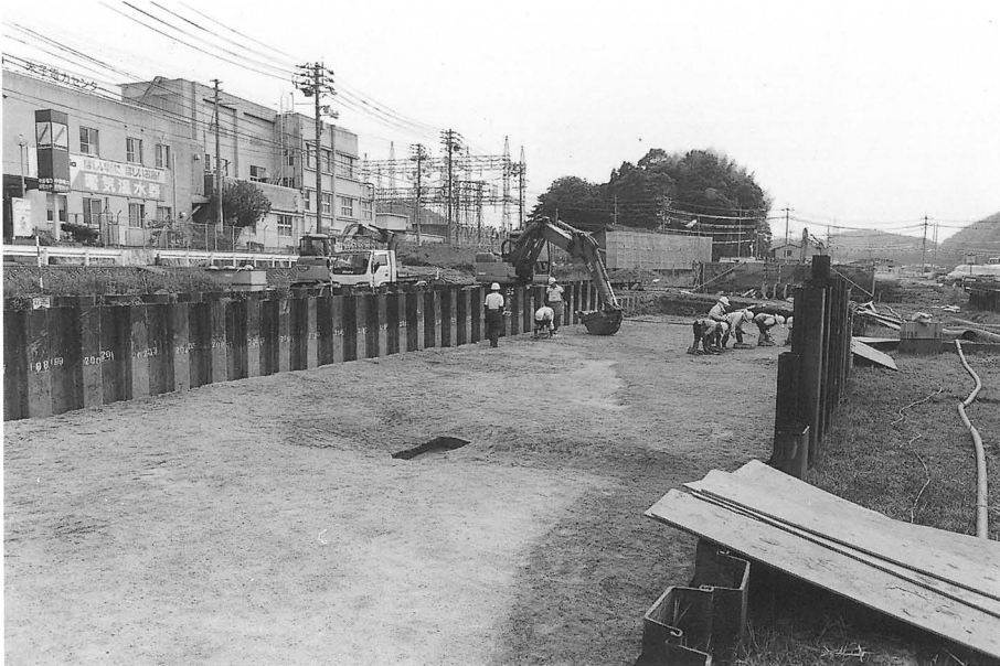
1. 1区調査風景 (北東より)
