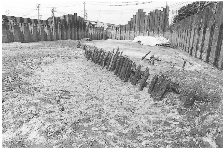
1. 1区護岸遺構 (西より)
