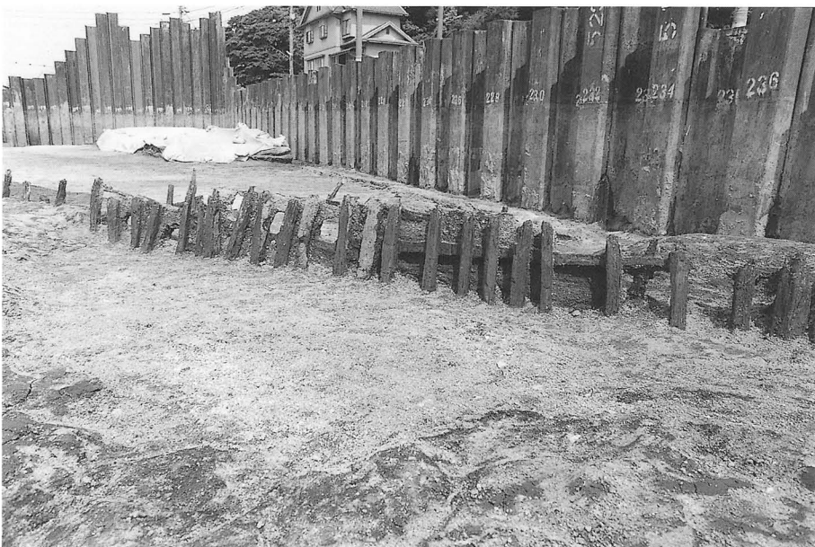
3. 1区護岸遺構 (北西より)
