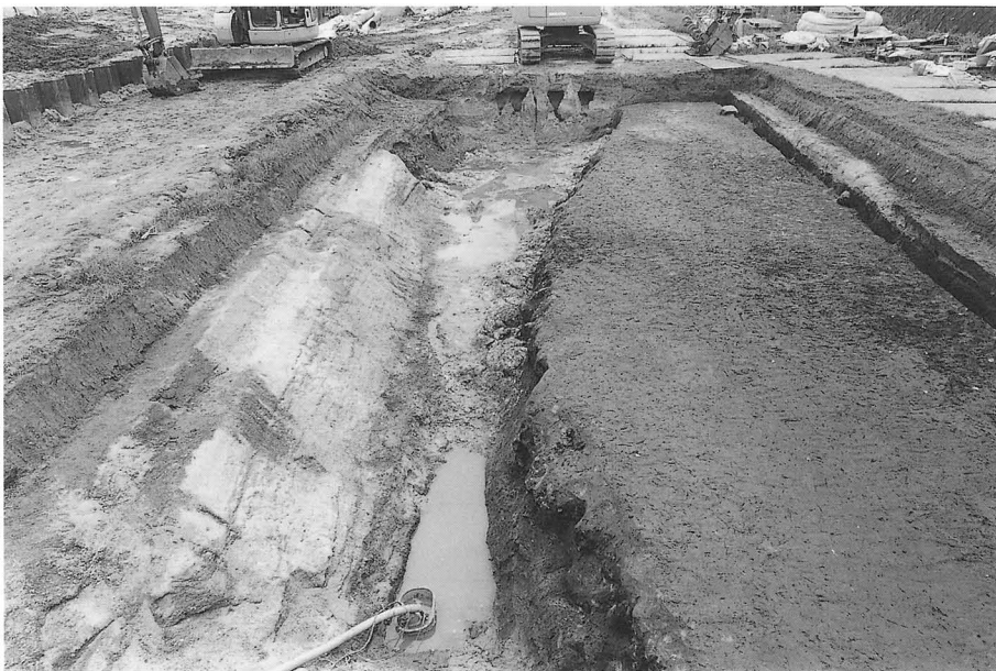
2. 2区水路3 完掘(西より)
