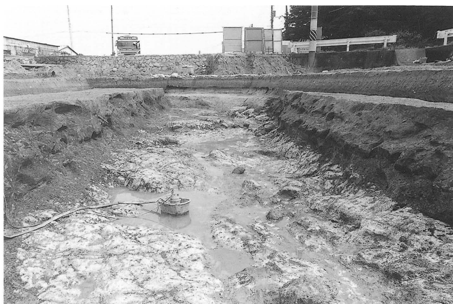
2. 3区水路3 完掘(西より)
