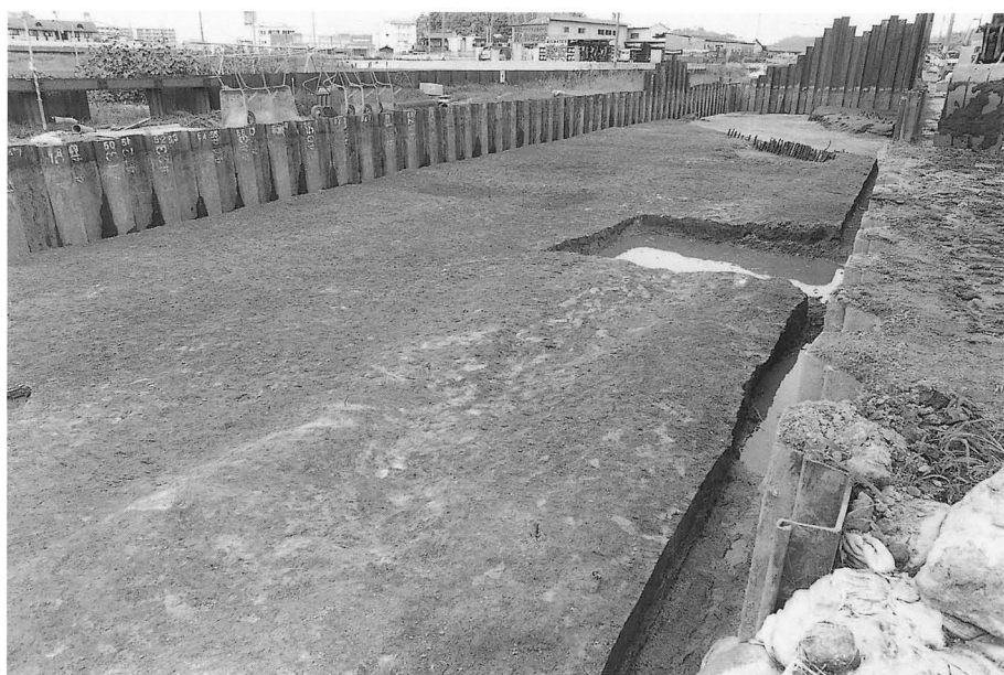
2.1区水田畦畔 (南西より)
