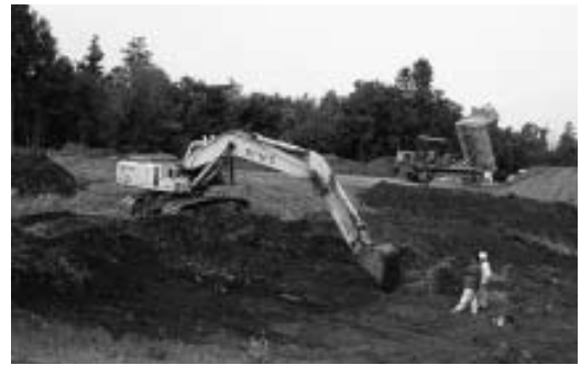
写真2 重機表土剥ぎ作業
