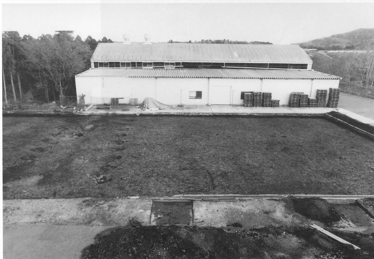
△調査後全景（北東から）
