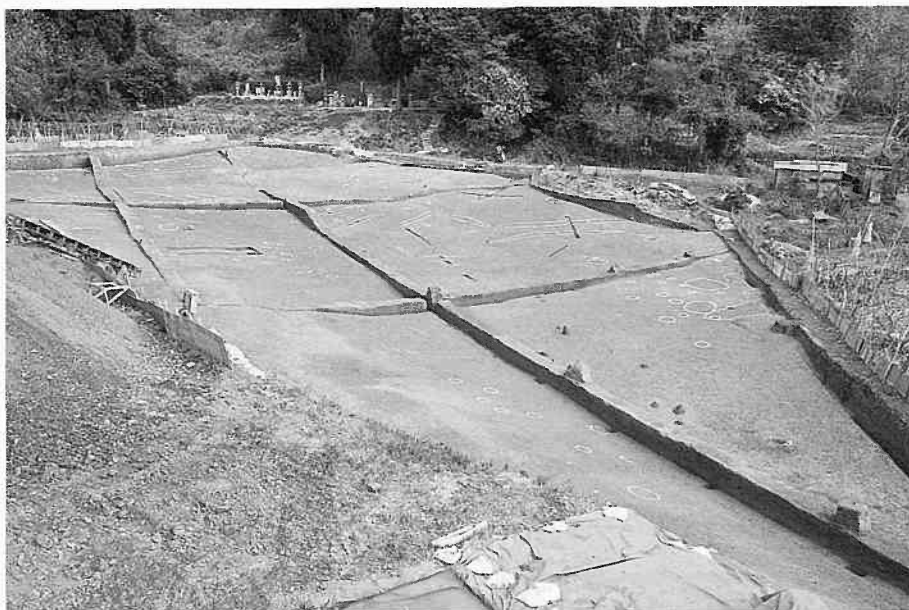
谷部土層ベルト設定状況 (南西から)
