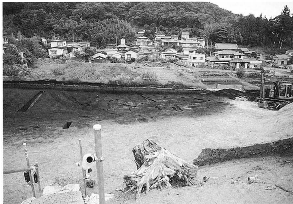
Ⅲ B・C区終了全景（南から）
