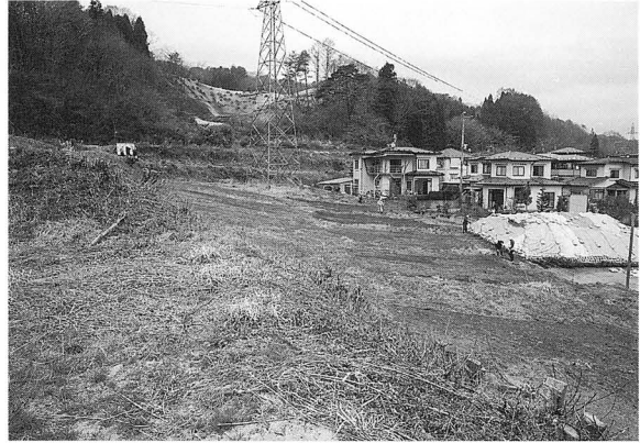
III B・C区調査前現況（東から）
