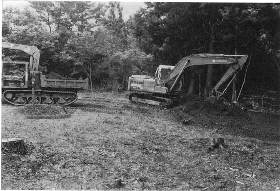
C 南側調査区表土除去状況
