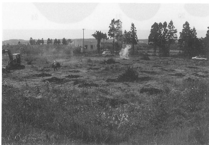
羽黒平(1)遺跡D区 リンゴ樹抜根立合い状況 (南東から)
