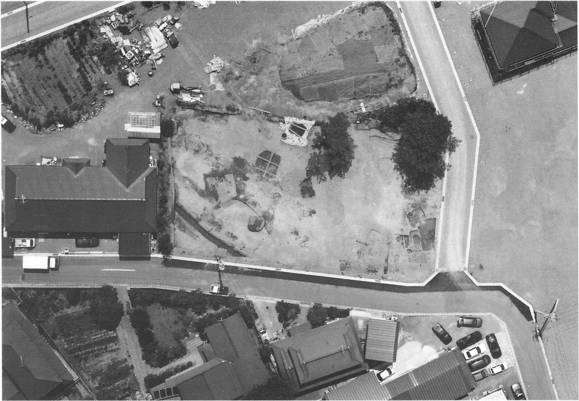
1. C区全景（北から）
