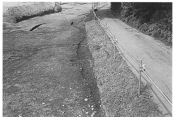
同左全景（西側・南西から）
