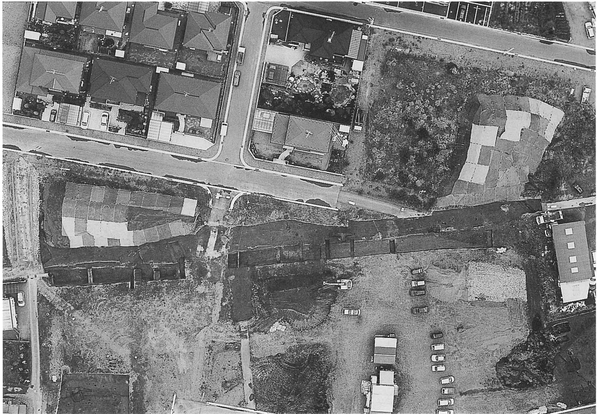
F区全景（空中写真）
