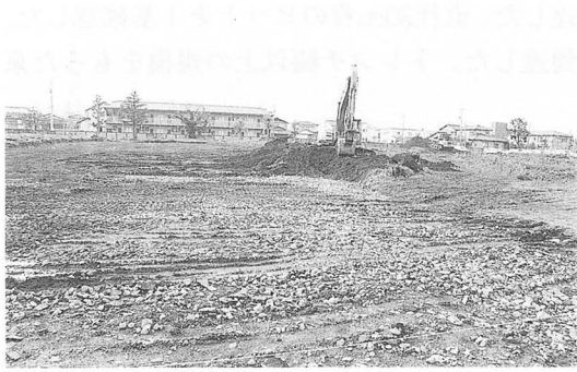
重機による表土掘削
