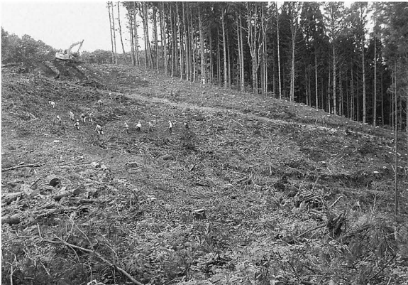
北東尾根部調査前全景（南東から）
