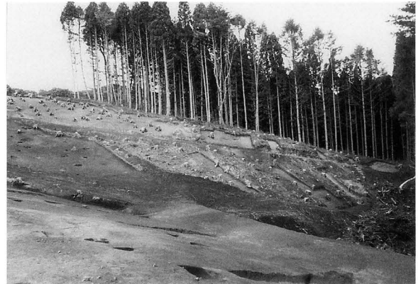
北東尾根部調査終了全景（南東から）
