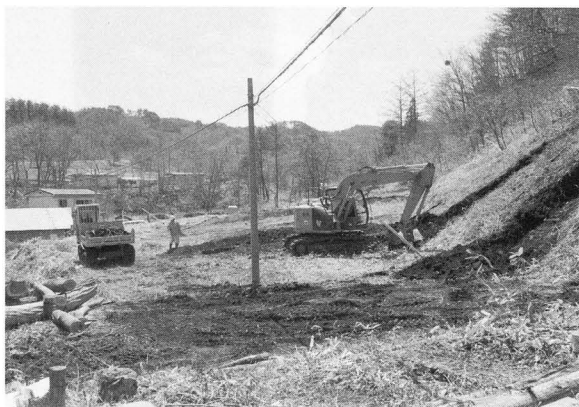
重機による表土掘削状況（北から）
