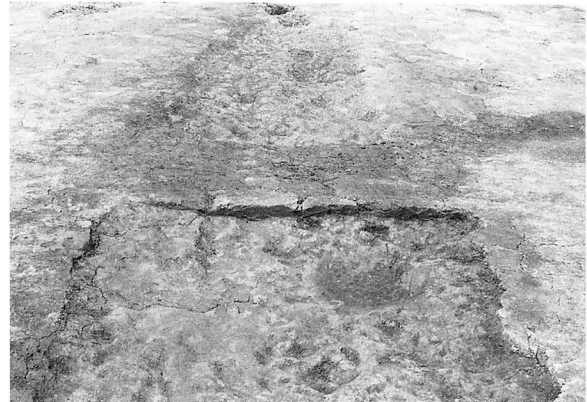
7号溝跡断面（南から）
