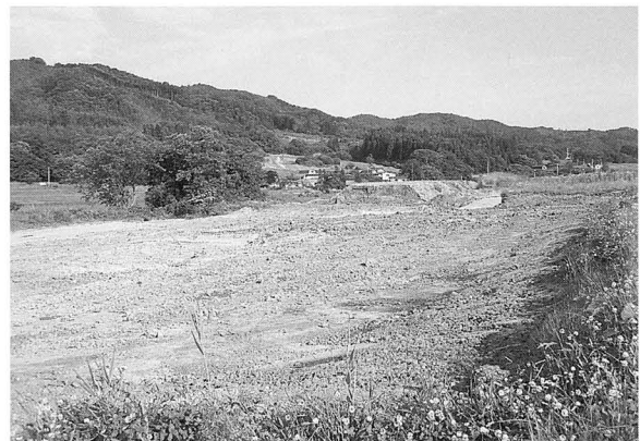
埋め戻し（北西から）
