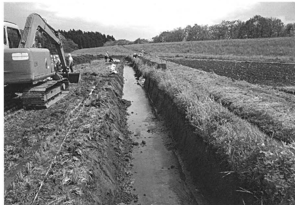
中央部調査区 T11 ④検出面 (北から)
