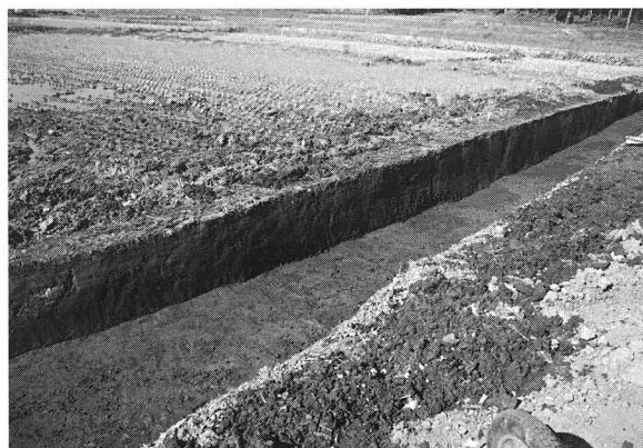
中央部調査区南東側検出面 (南から)
