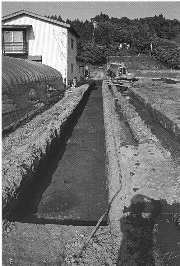
北部調査区の東側検出面（西から）
