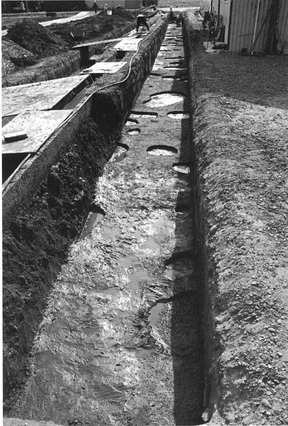
柱穴群 4 検出 (東から)
