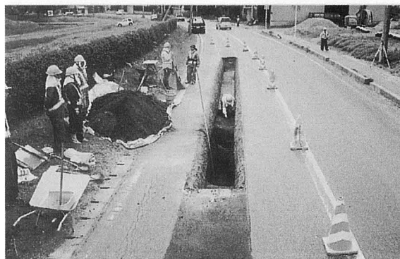
SH01掘り下げ状況（東から）
