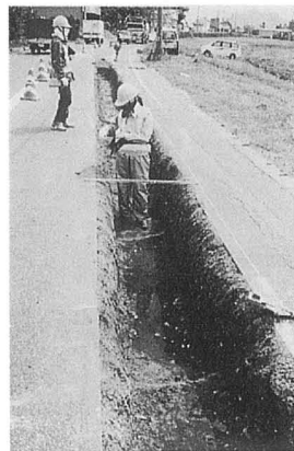
SH04調査状況
