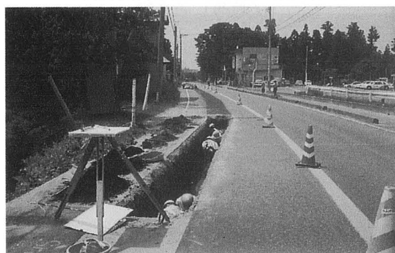
SH07調査状況（東から）
