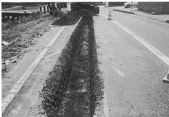
舗装除去状態
