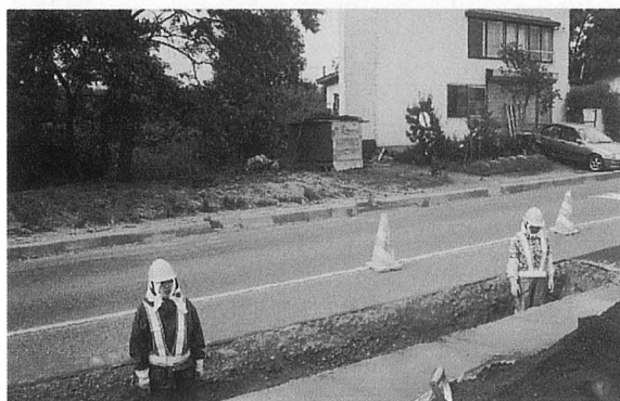
SH01掘幅（作業員間、南から）
