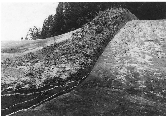
断面②（西から）
