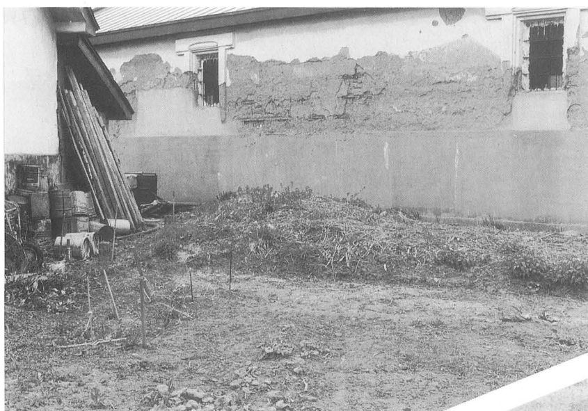
(1) D区調査前状況 (東から)
