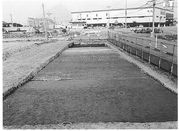
V区全景 (西から)
