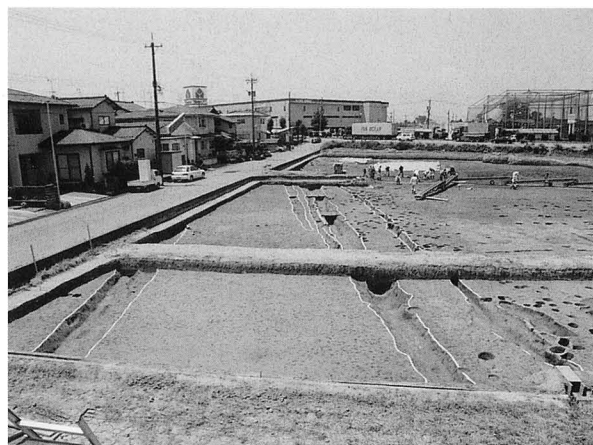
古代北陸道全景 (東から)
