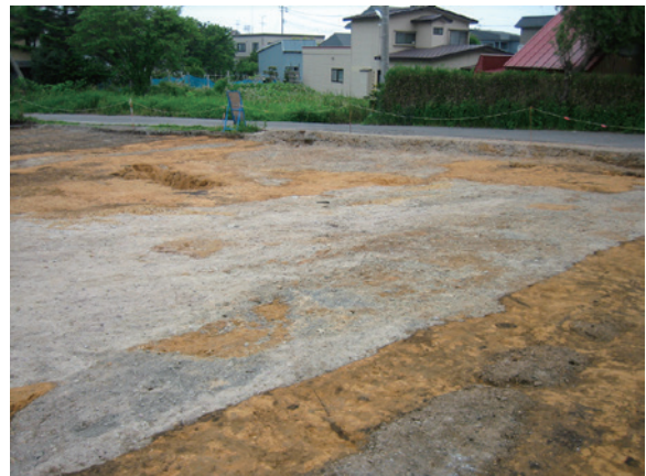
写真1-34 D区調査区風景
