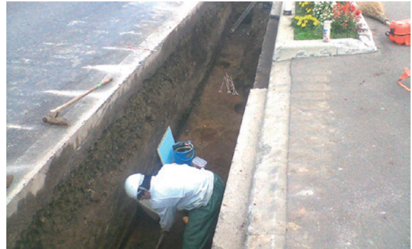
写真1-66 C地点トレンチ2作業風景(W→)
