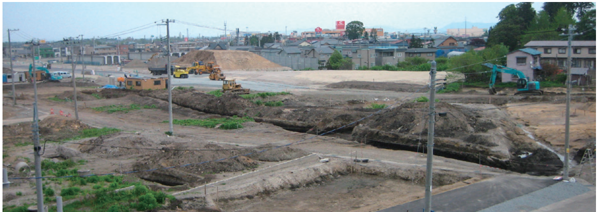
写真1-26 B区SD-001・調査区遠景(SW→)
