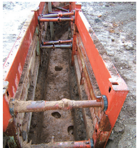
写真1-62 B地点トレンチ19(S→)
