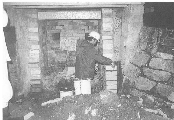
写真-75 下焚口煉瓦積み修復
