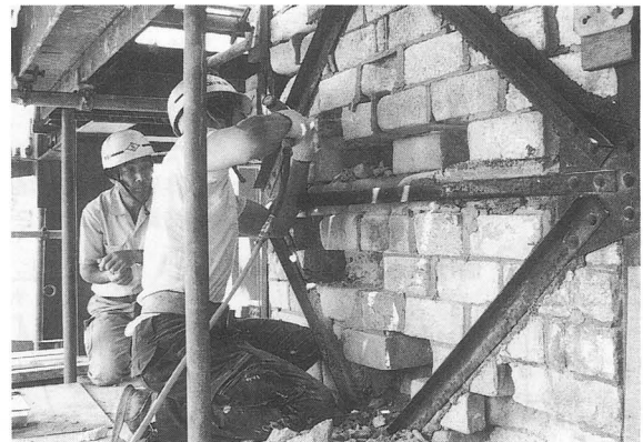
写真-94 既存煉瓦撤去
