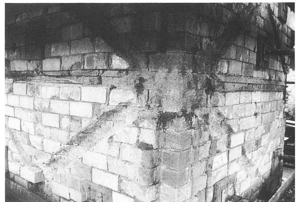
写真-39 既存補強鉄骨解体後
