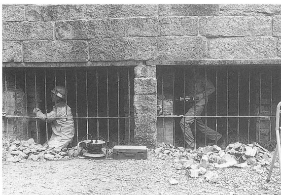
写真-44 北炉下焚口赤煉瓦控柱解体後
