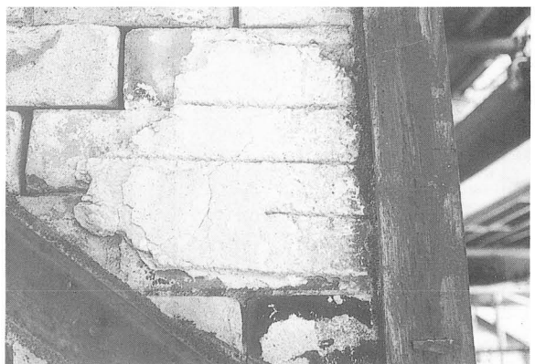
写真-174 漆喰残存状況（南炉東面）
