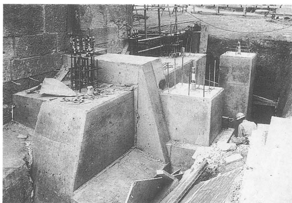
写真-54 基礎工事 第二工区
