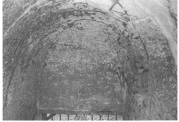
写真-145 炉内（北A炉焚口側）
