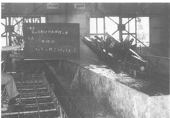
写真-80 補強用鉄骨 (亜鉛メッキ処理)
