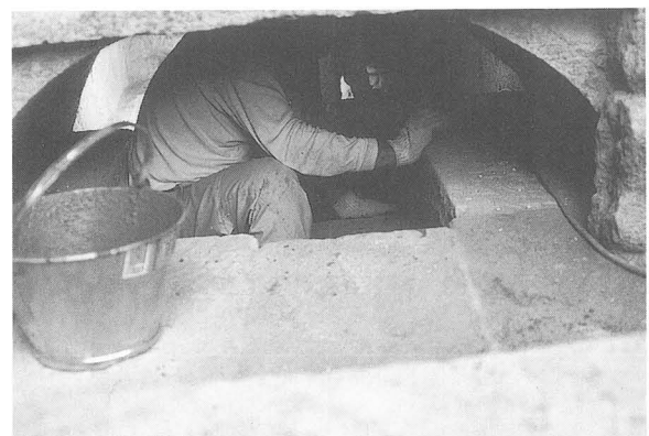
写真-68 炉下束石補強工事
