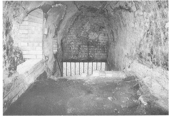
写真-147 炉内（北B炉焚口側）
