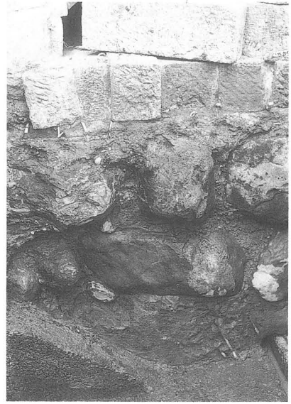
写真-124 北A炉基礎部分
