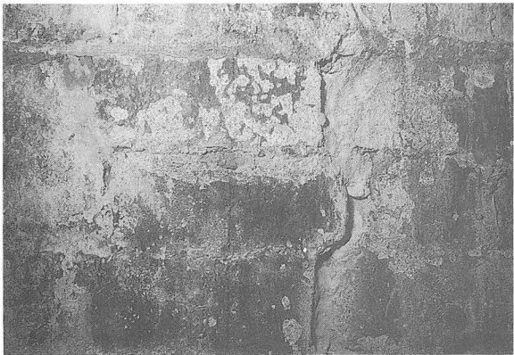
写真-177 煙突内部（北B炉）
