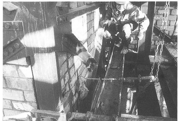
写真-108 煙突内部注入補強工事
