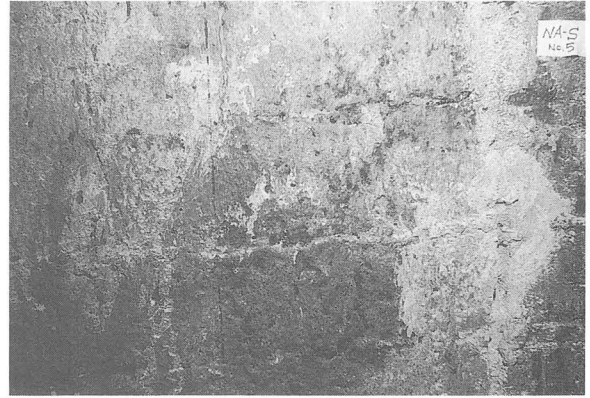
写真-176 煙突内部（北A炉）
