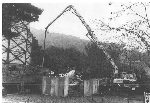
写真-52 基礎工事 第一工区（コンクリート打設）
