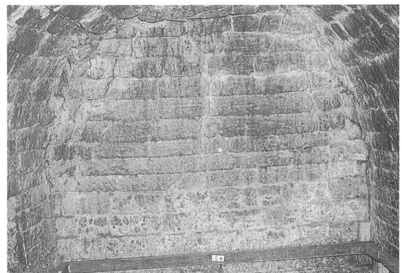
写真-151 炉内（南B炉焚口側）
