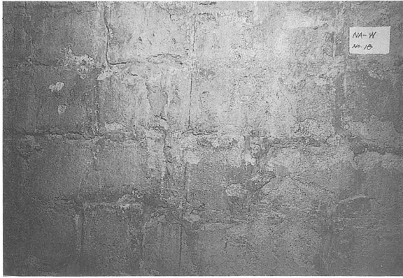
写真-175 煙突内部（北A炉）
