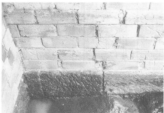
写真-134 下焚口側基礎（南B炉）
