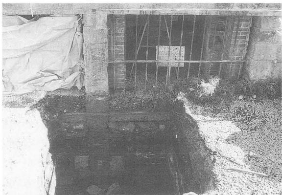
写真-129 下焚口側基礎調査箇所（北炉）
