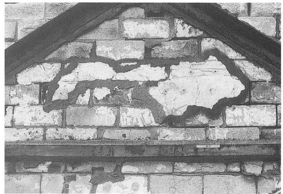
写真-102 漆喰保存修理後
