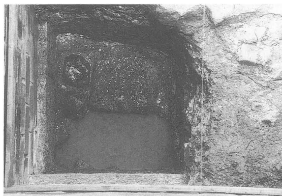
写真-132 下焚口側基礎（北A炉）
