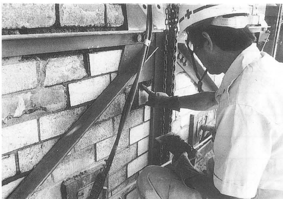
写真-97 煉瓦目地仕上げ
