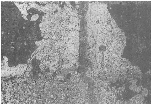
写真-179 煙突内部（南A炉）
