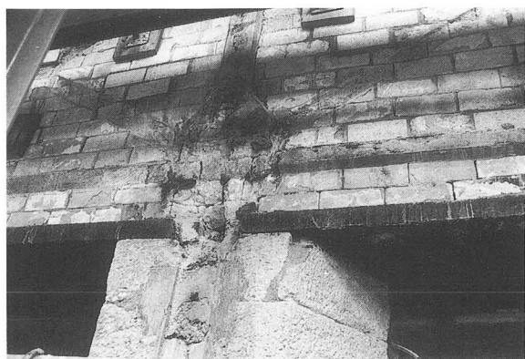
写真-40 既存補強鉄骨解体後
