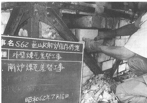
写真-95 煉瓦取付け
