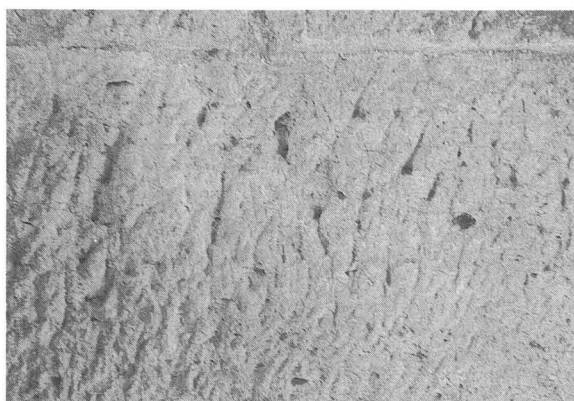
写真-232 炉体伊豆石の表面加工
