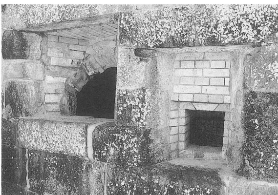
写真-153 炉体外観（南炉）
