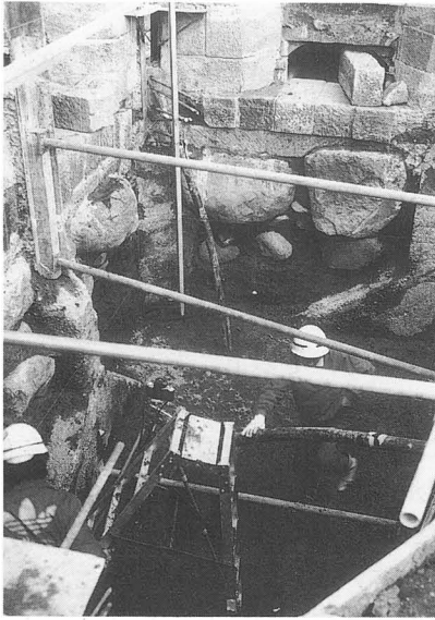
写真-123 湯口側基礎調査状況
