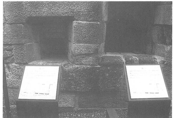
写真-118 内柵, サイン設置後 (鑄口)
