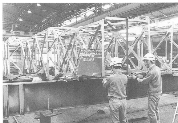
写真-82 補強用鉄骨 (仮組み)
