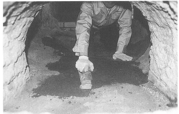
写真-71 炉床三和土欠損部補修
