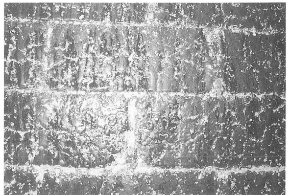
写真-182 煙突内部（南B炉）
