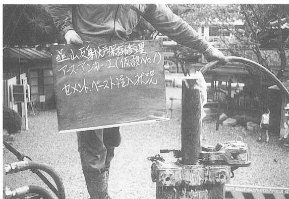
写真-48 アースアンカー工事(ペースト注入)
