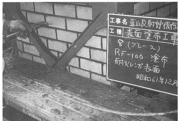
写真-104 外壁煉瓦劣化防止
