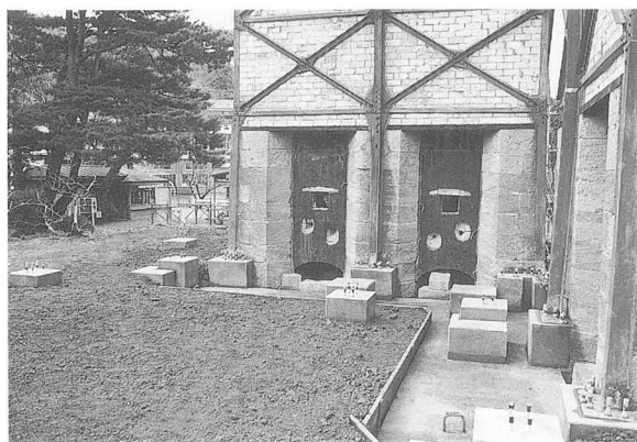
写真-58 基礎工事 第四工区
