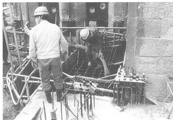
写真-59 基礎工事 第四工区 (コンクリート打設)
