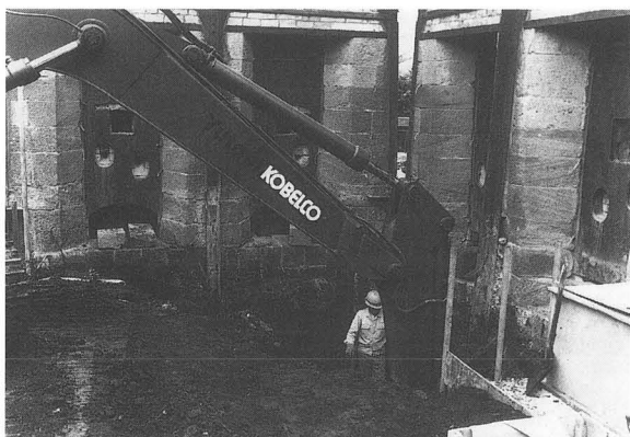
写真-56 基礎工事 第四工区 (掘削)
