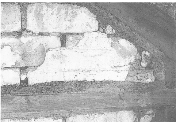
写真-173 漆喰残存状況（南炉西面）
