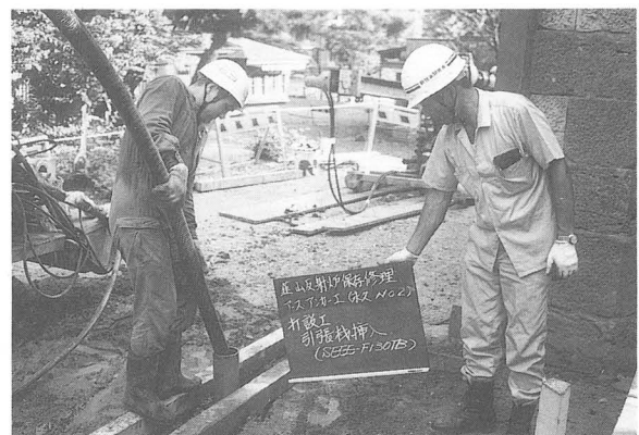
写真-47 アースアンカー工事(引張材挿入)
