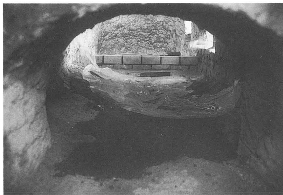
写真-70 炉床三和土欠損部補修
