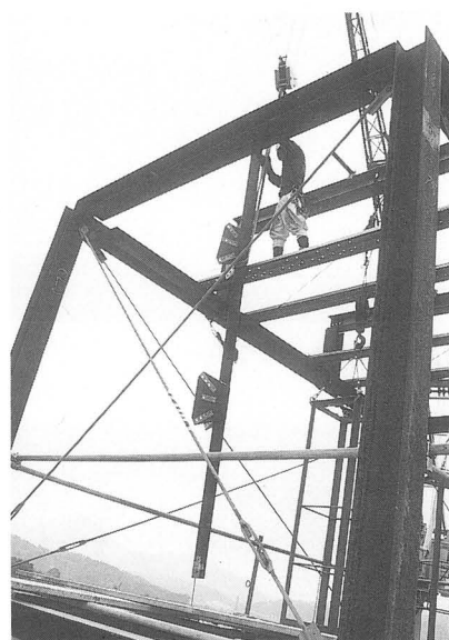
写真-84 補強用鉄骨 (組立)
