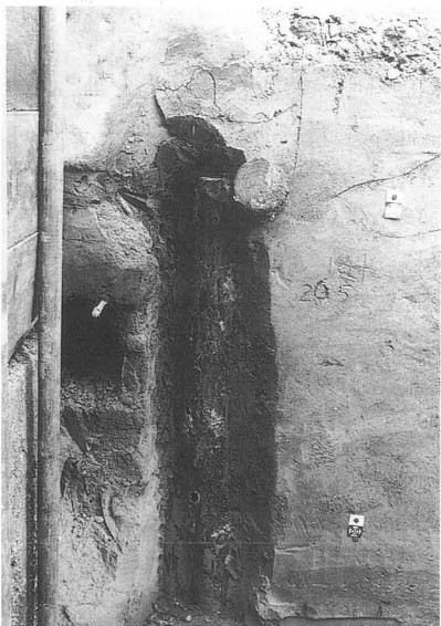
写真-127 松杭（北A炉）
