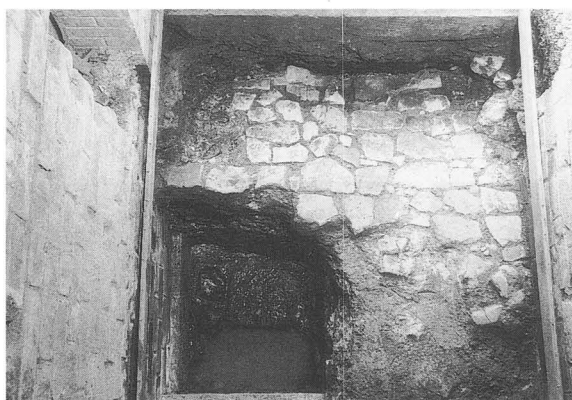
写真-140 下焚口(北A炉)
