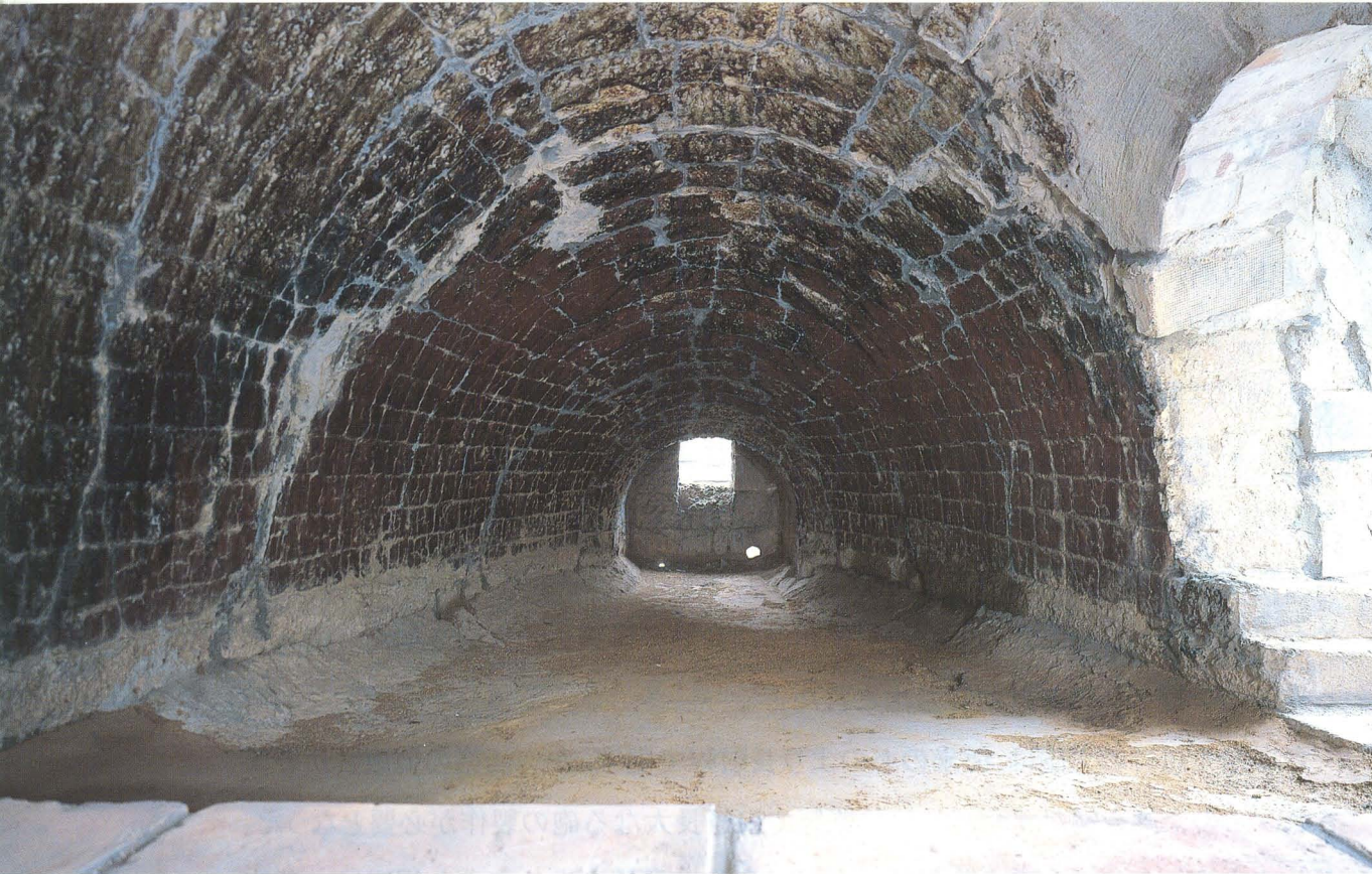
写真-2 炉内 (南B炉の中 から出湯口 側を見る)
