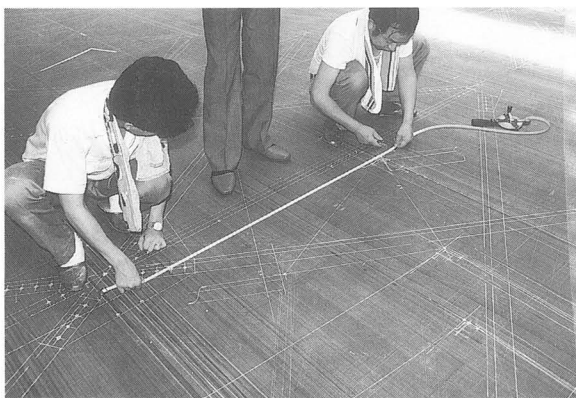
写真-78 補強用鉄骨 (現寸図)
