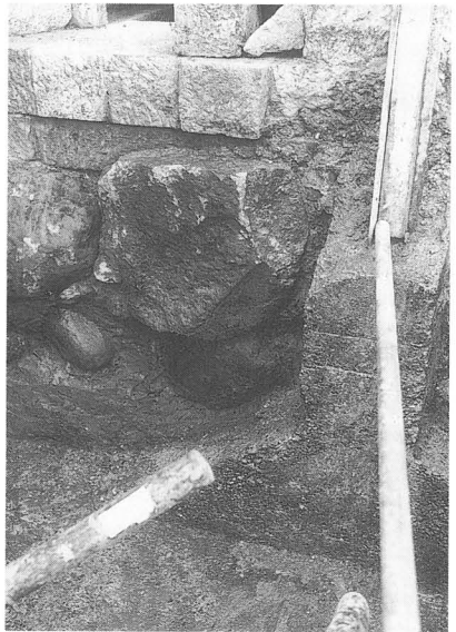
写真-126 南B炉基礎部分
