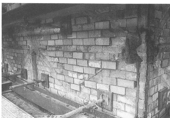
写真-31 補強ジャッキ (煉瓦面支持)
