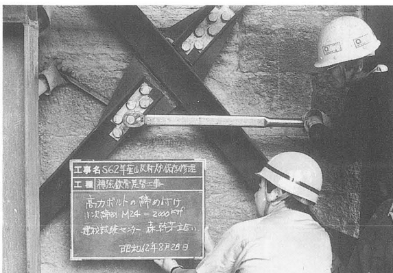
写真-87 補強用鉄骨(高力ボルト締め付け)
