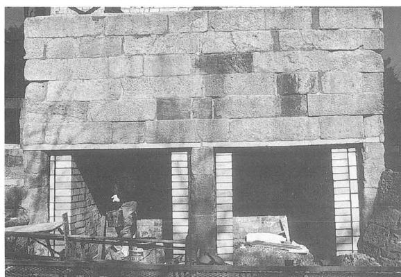
写真-76 下焚口煉瓦積み修復
