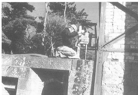
写真-64 伊豆石補強工事（穿孔）
