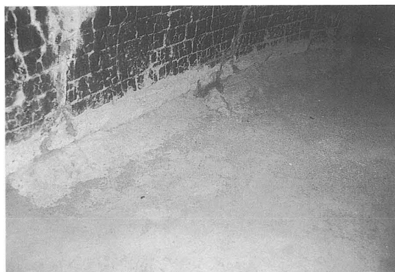
写真-72 炉床三和土欠損部補修（南B炉）
