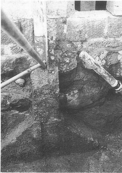
写真-125 南炉基礎部分
