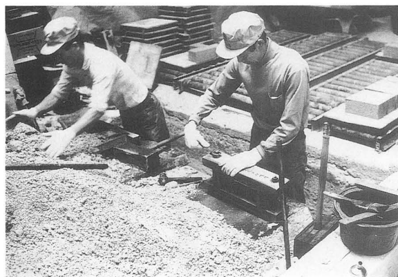
写真-91 煉瓦製作(脱型)
