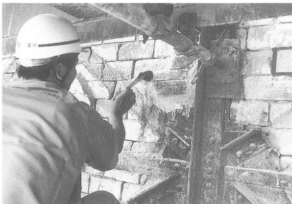
写真-101 漆喰保存修理
