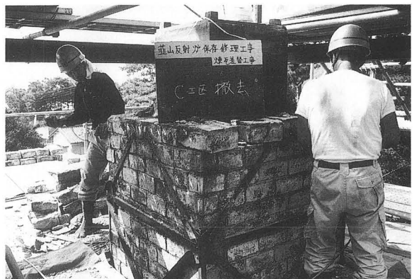
写真-41 煙突最上部解体
