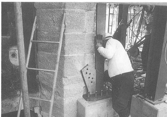
写真-85 補強用鉄骨(組立)
