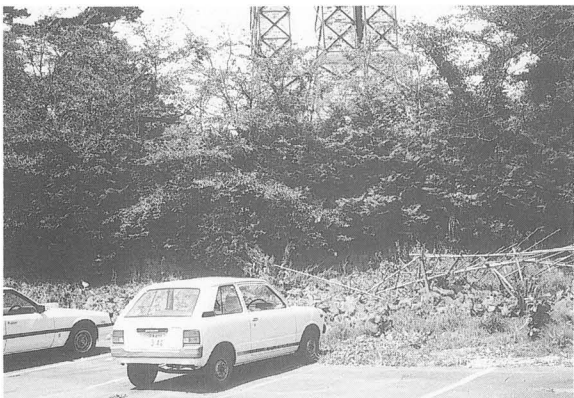
写真-115 外柵 設置前
