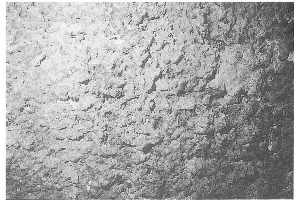
写真-178 煙突内部（北B炉）
