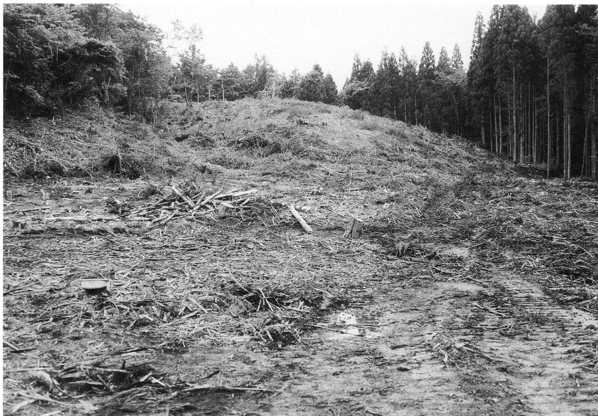
尾根部現況（南から）
