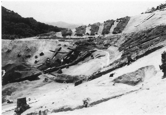
南尾根トレンチ掘削状況
