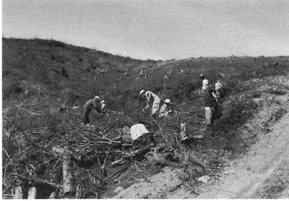
雑木撤去作業
