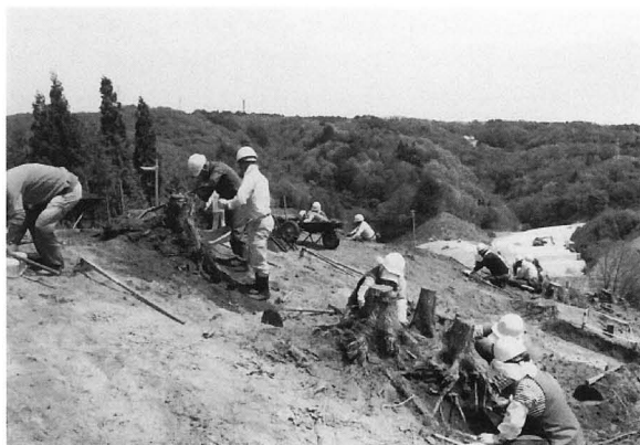
切株除去作業
