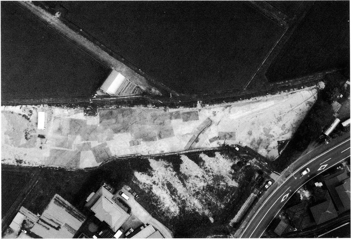
調査区中央航空写真（直上）
