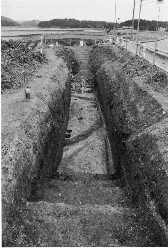
南西調査区終了全景（西から）
