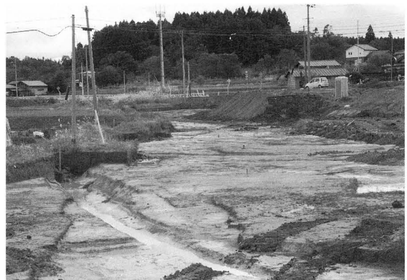
調査終了全景 (北から)
