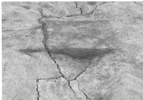
7号溝断面（西から）
