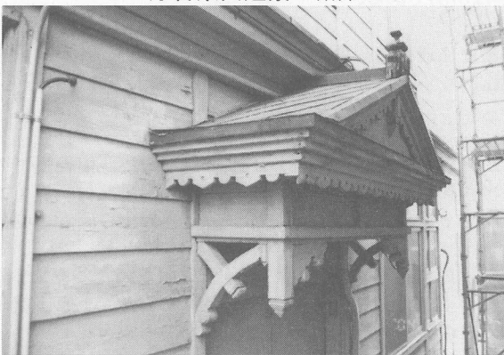
7 庁舎正面玄関底 南西から
