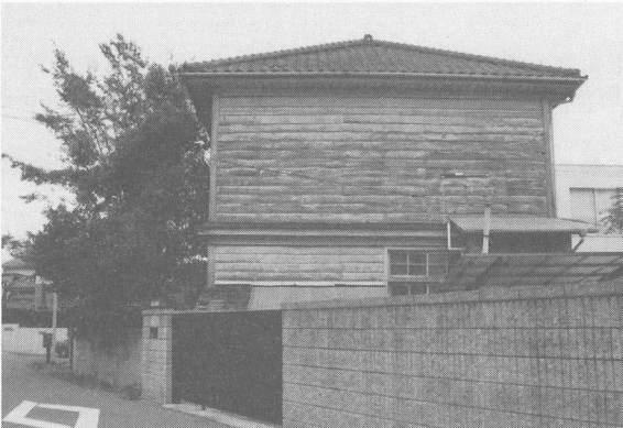
3 庁舎西面 西から
