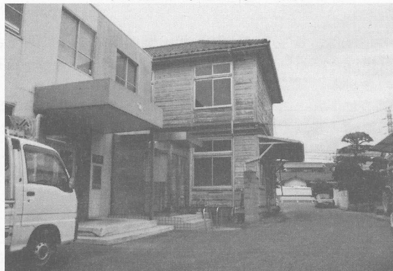
4 庁舎南面(東部)近景 南から
