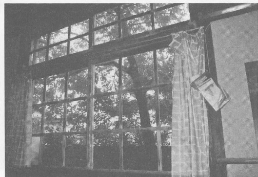
4 宿直室北部屋窓 南東から
