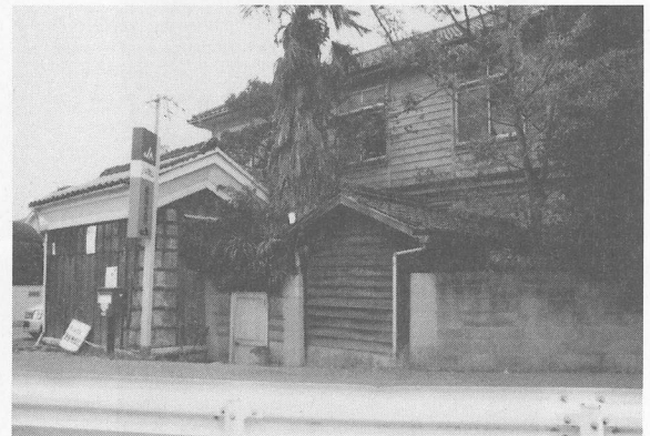
7 倉(左)と便所 手前は県道 北西から
