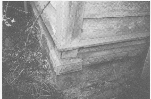
5 礎石(北西隅) 北西から
