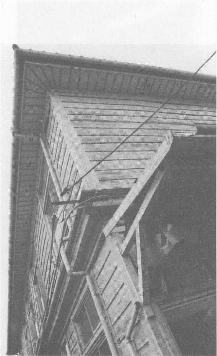
3 屋根裏面の状況 南東隅部
