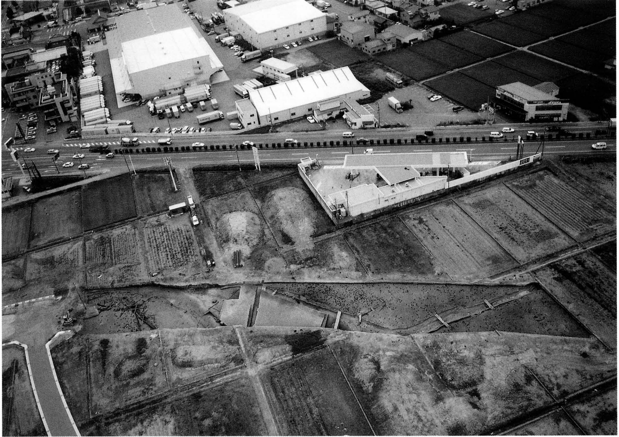
A区 全景(北西から)
