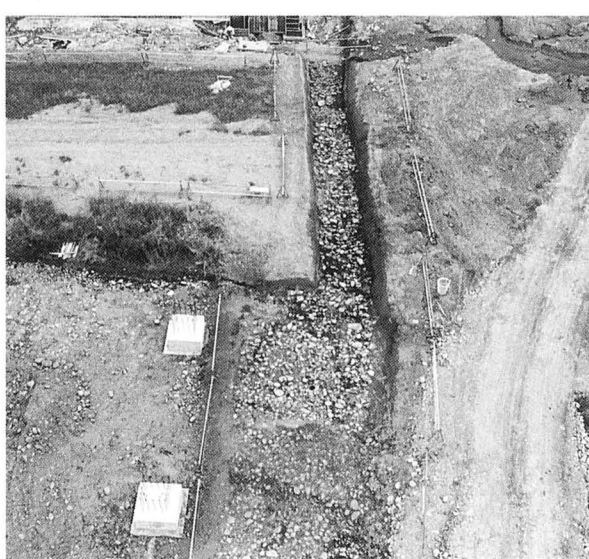
⑧ B-3区 (北より)
