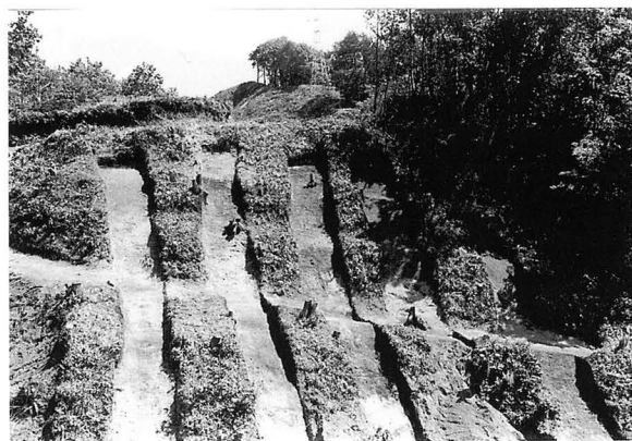
T48~52掘削状況 (北西から)
