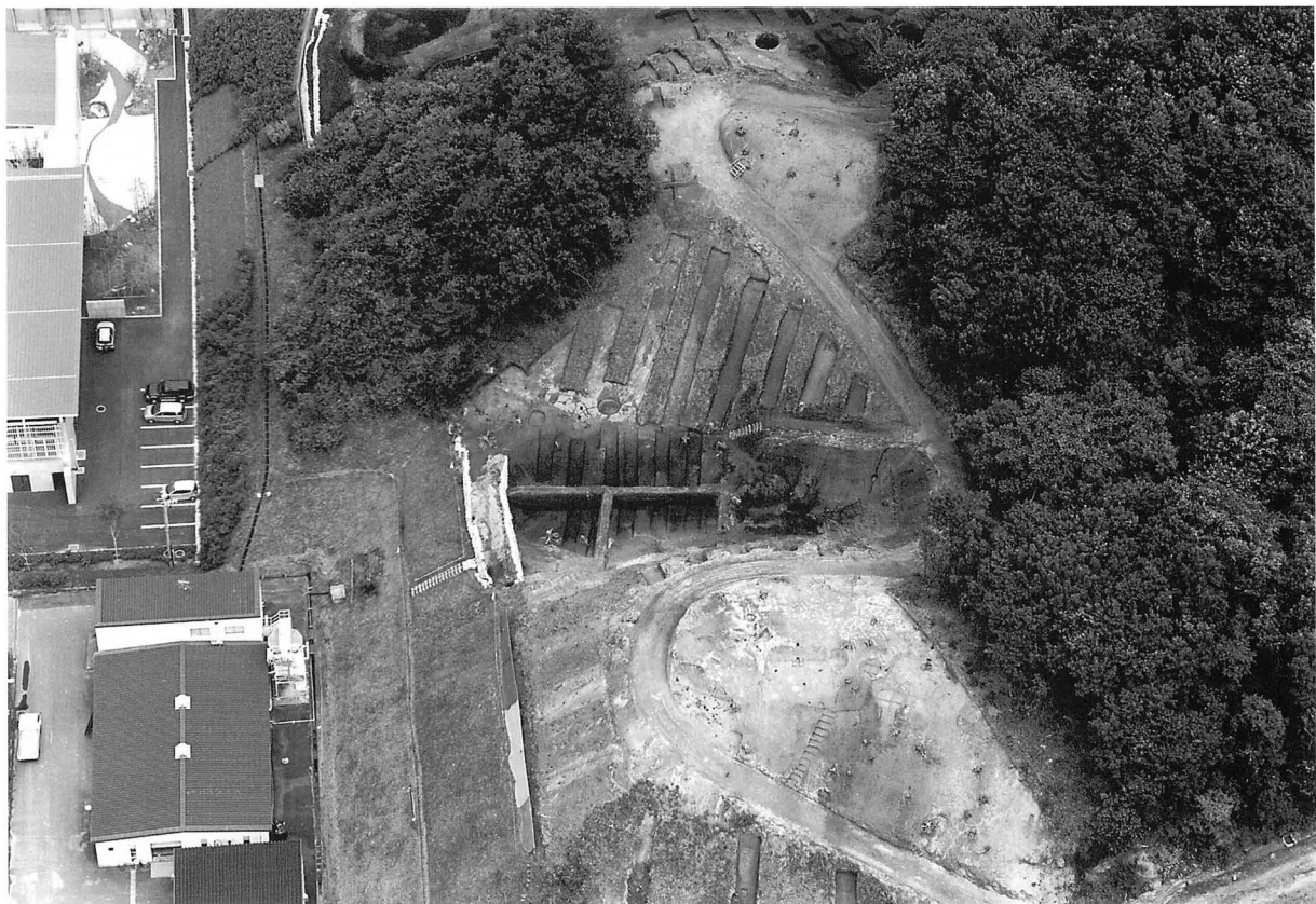
調査区南半部全景（南から）
