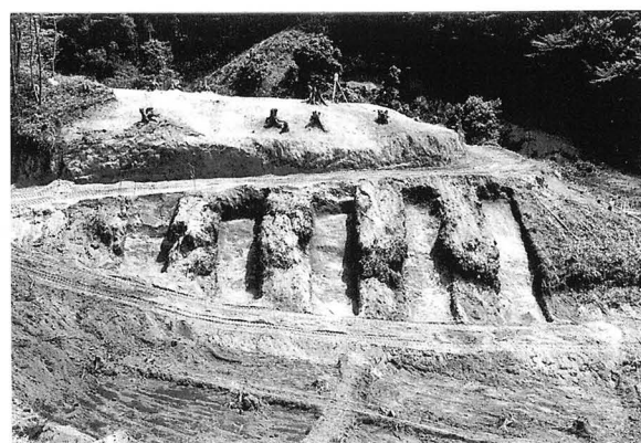
T40~44掘削状況 (北から)
