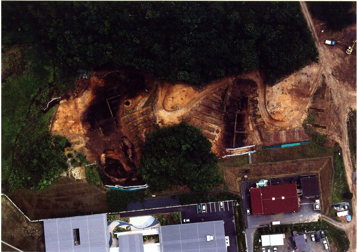
木戸井内Ⅳ遺跡空中写真（近景）
