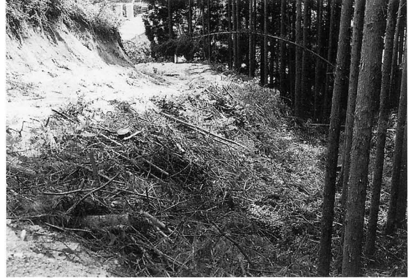
調査前の近景（北から）
