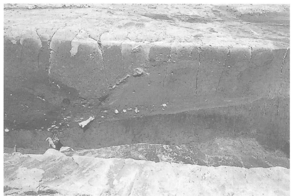
第4図 堀肩・土居築成の状況
