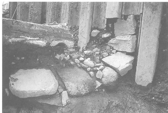
第7図 堀南岸護岸の様子
