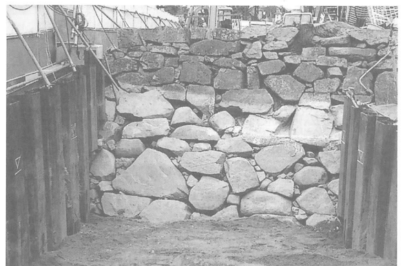
第2図 石垣上半部
