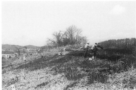
作業風景（屋根部）
