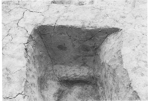
RD1189断面(北から)
