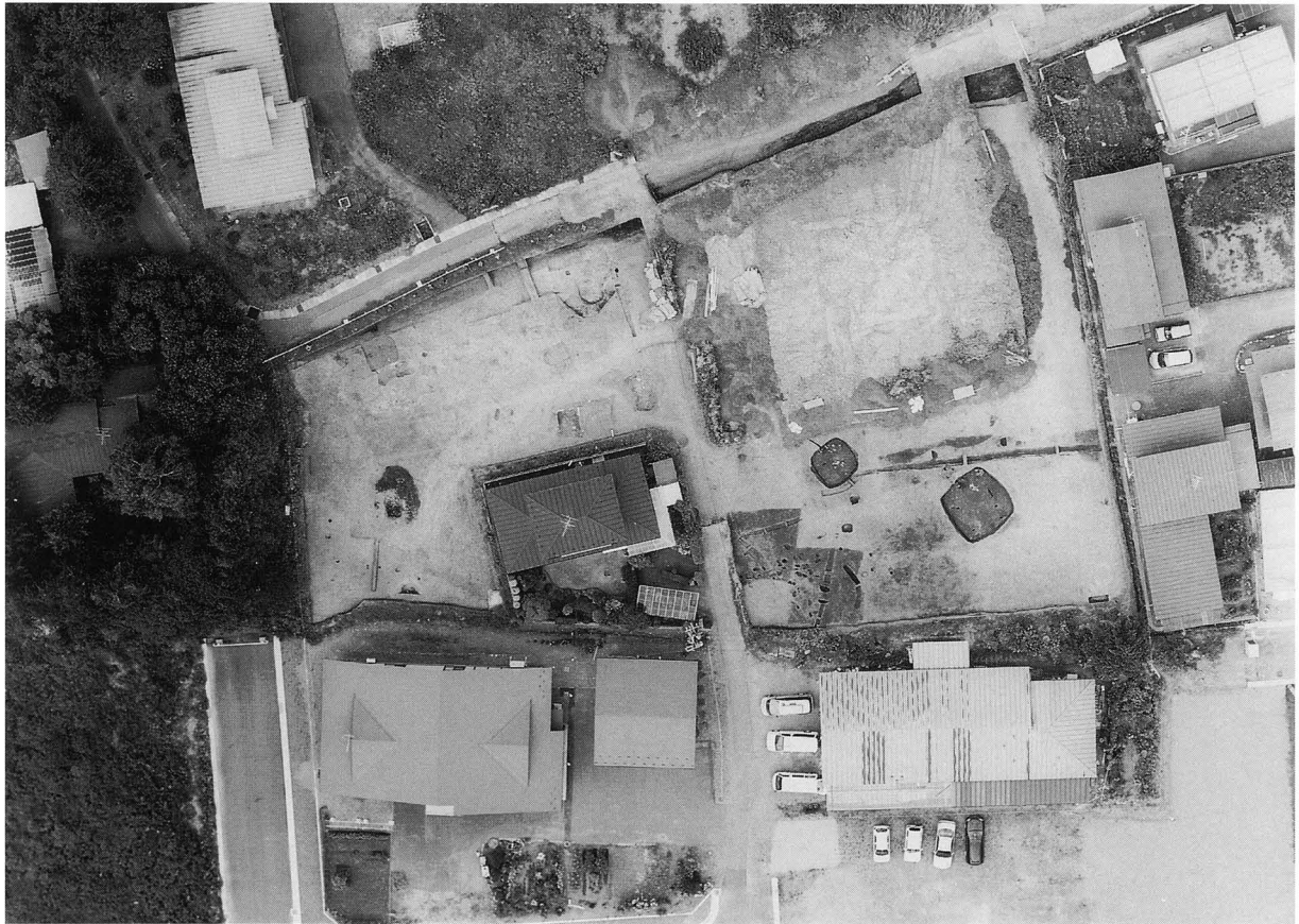
Ⅱ区近景(直上・写真上が北)
