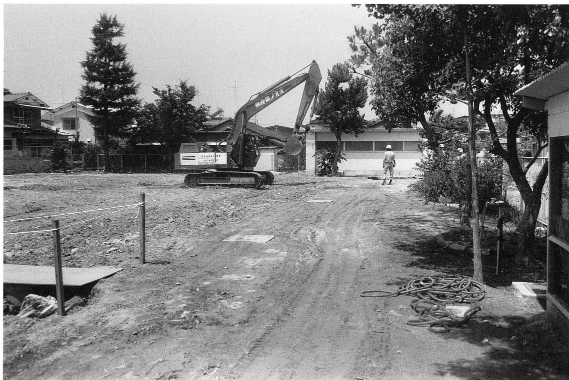
調査前全景（東より）
