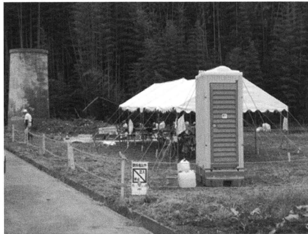
2. トイレ設置状況
