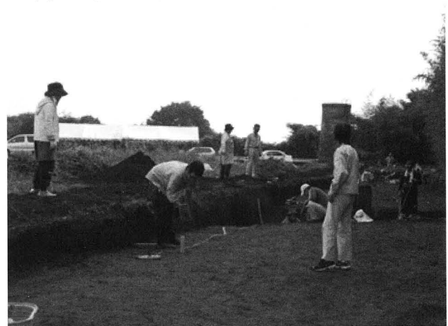
5. 作業風景（杭打設状況）
