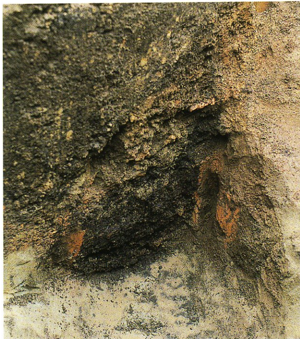
4 1号製鉄炉断面（炉体を斜めに破壊される）
