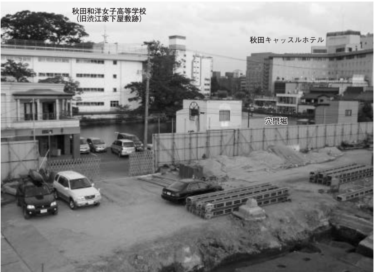
2 遺跡近景（北西から）
