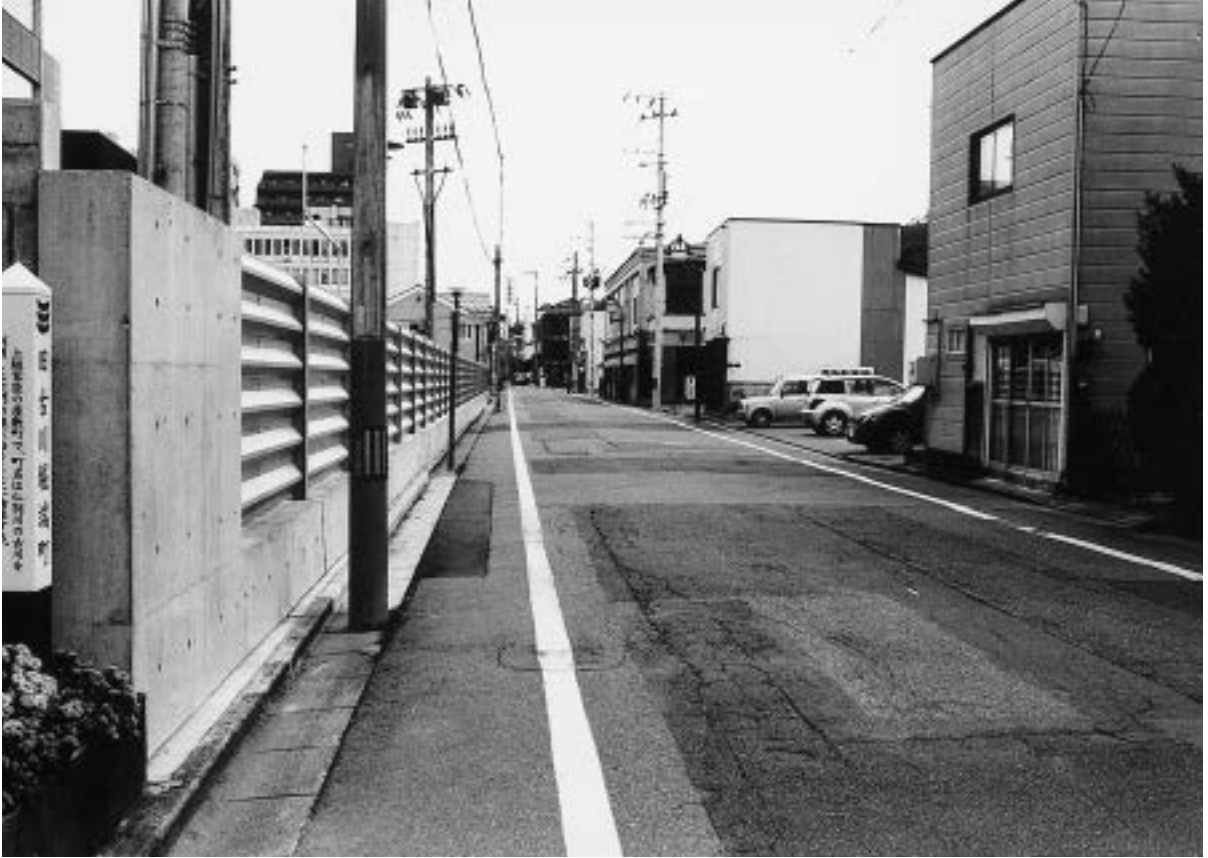
1 現在の古川堀端通り（北から）
