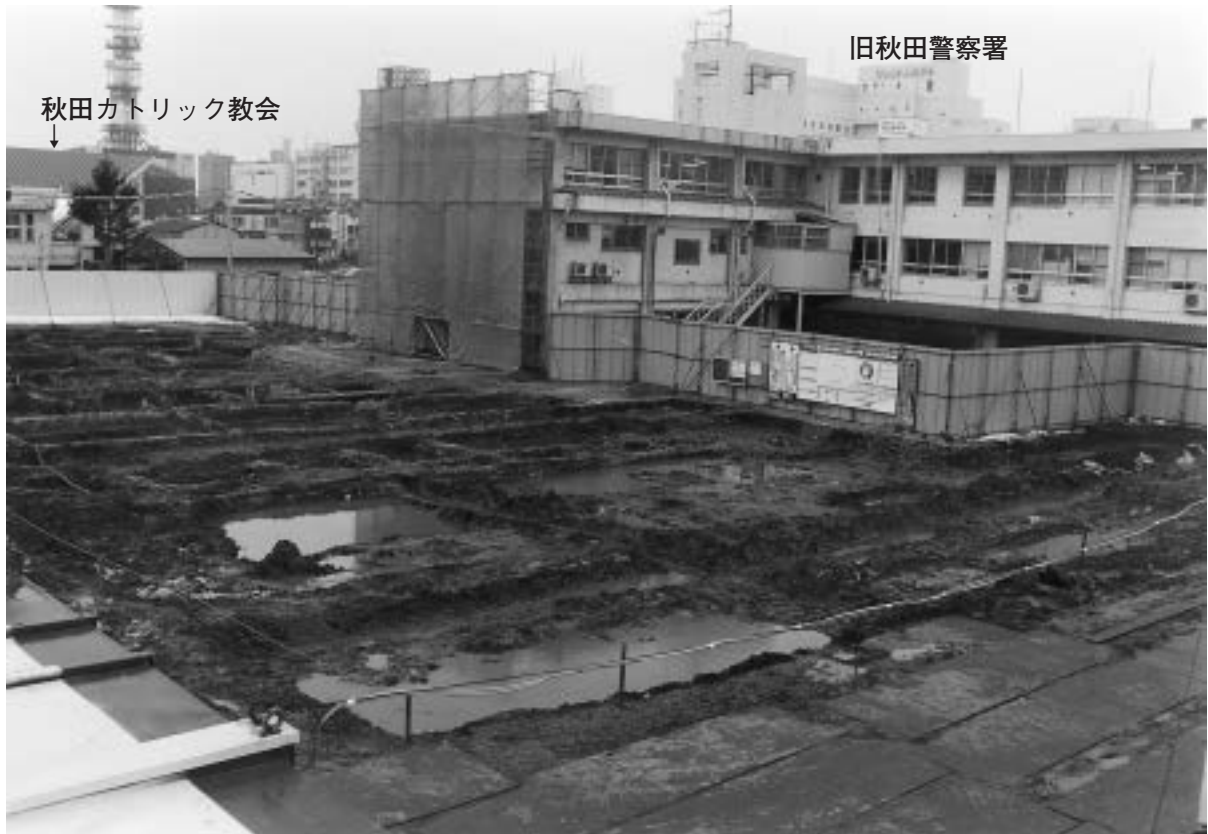
1 表土除去後の調査区 (北東から)
