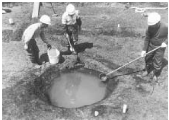
6 S E 01作業風景
