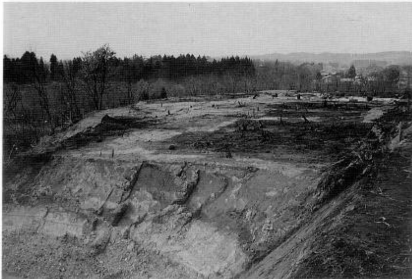
(中) 大型重機で削平され 遺構プランが露出した 状況(南西側から) (1996. 5. 20 撮影)
