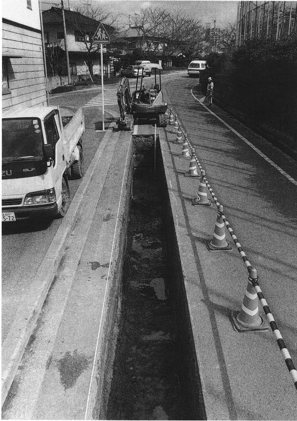
写真1 T7完掘状況（西より）
