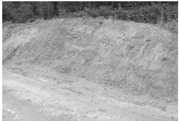
調査後C区横断面（北西→）
