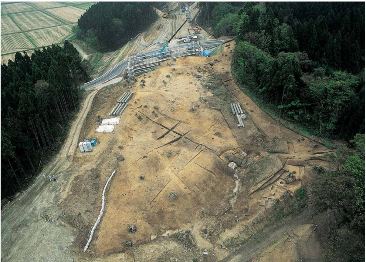
2 平成16年度調査区全景(南西から)
