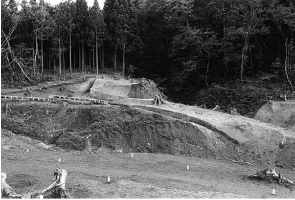
1 S F 945確認状況 (西から)
