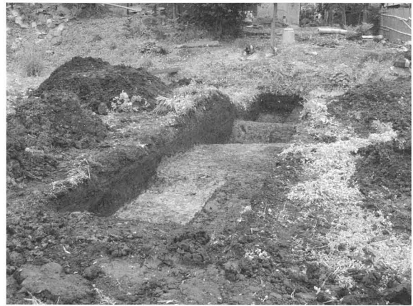
トレンチ10 セクション
