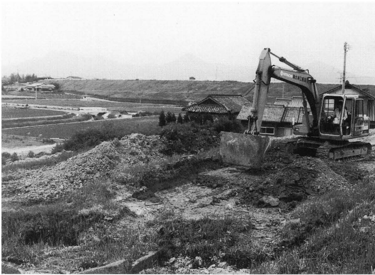
写真 6 5 東原遺跡D区調査前近景
