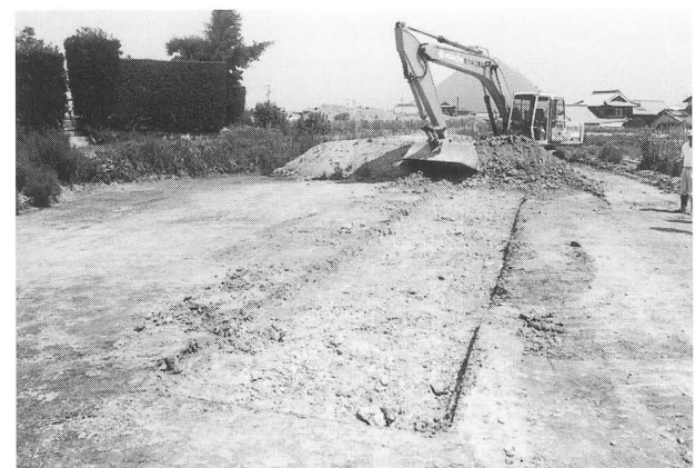
写真18 東原地区12トレンチ全景
