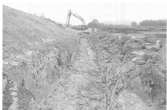
写真48 2トレンチ全景
