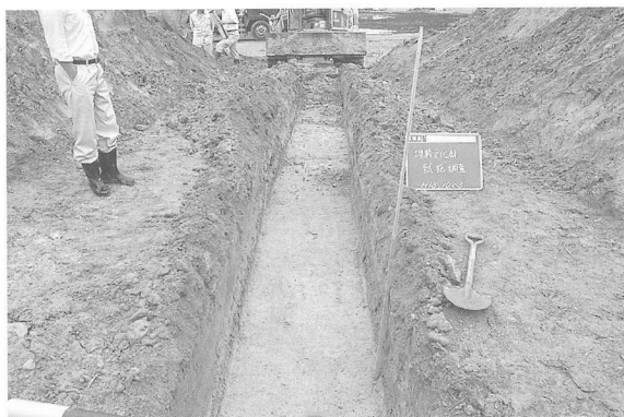
写真49 1 トレンチ全景
