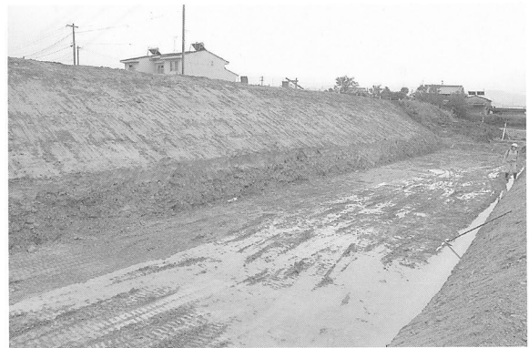
写真50 2 トレンチ全景
