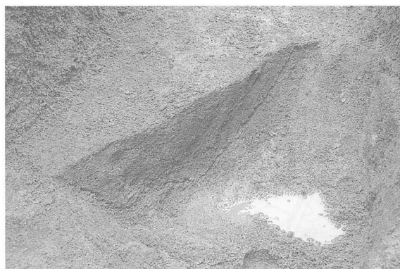
写真28 1 トレンチ溝 1 断面
