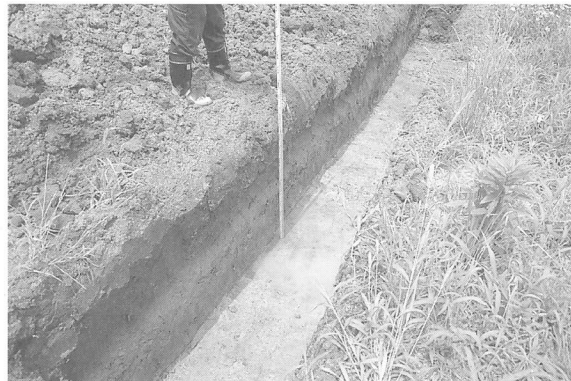
写真16 2トレンチ 旧河道検出状況
