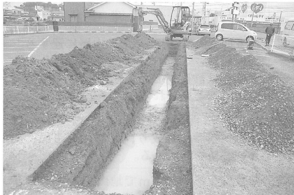
写真15 1トレンチ 全景
