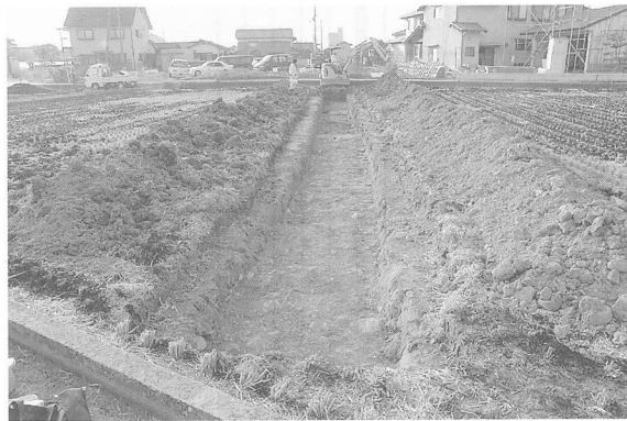
写真21 13トレンチ全景
