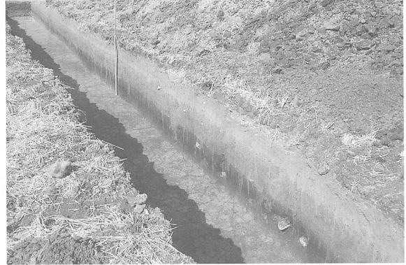
写真18 8トレンチ旧河道検出状況
