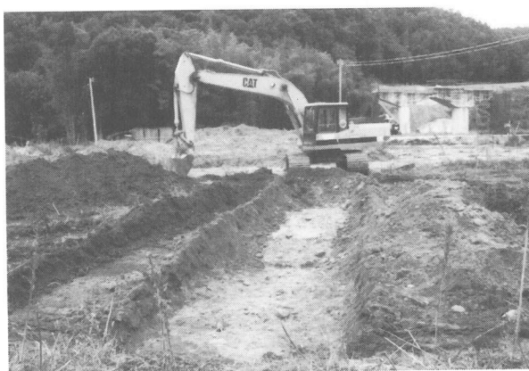
写真75 5トレンチ全景
