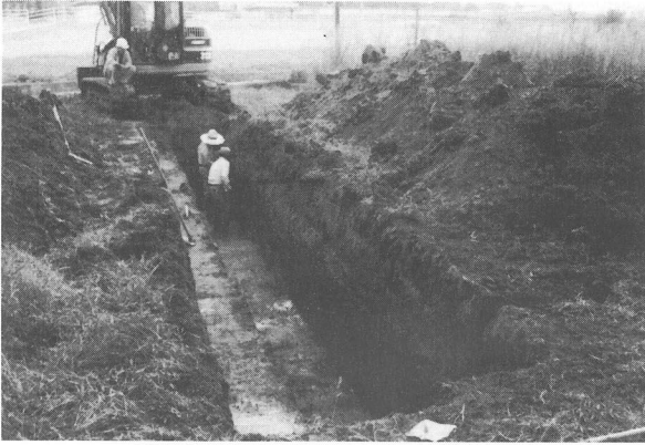
写真67 1トレンチ全景
