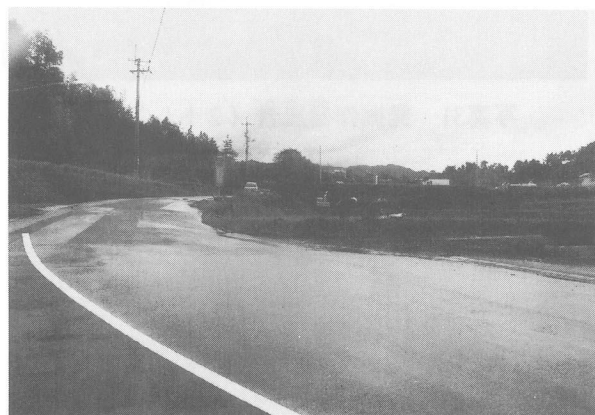
写真34 対象地全景(北より)
