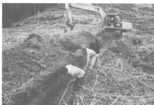
写真10 作業風景（3トレンチ）
