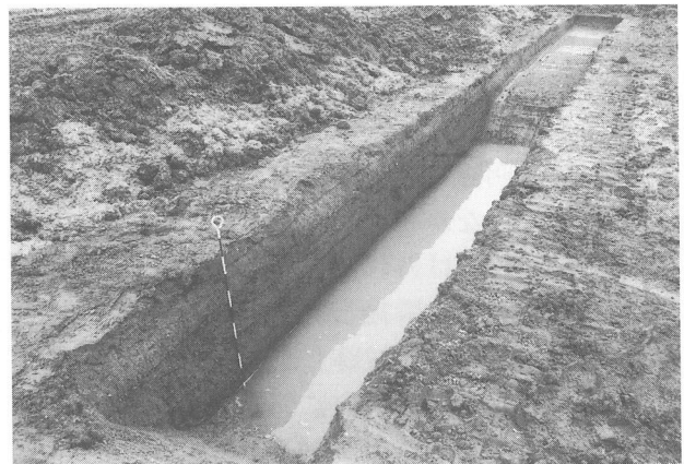
写真26 3 トレンチ自然河川
